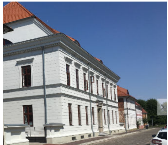
Nach der Sanierung: Stadtverwaltung Foto: Wimes
