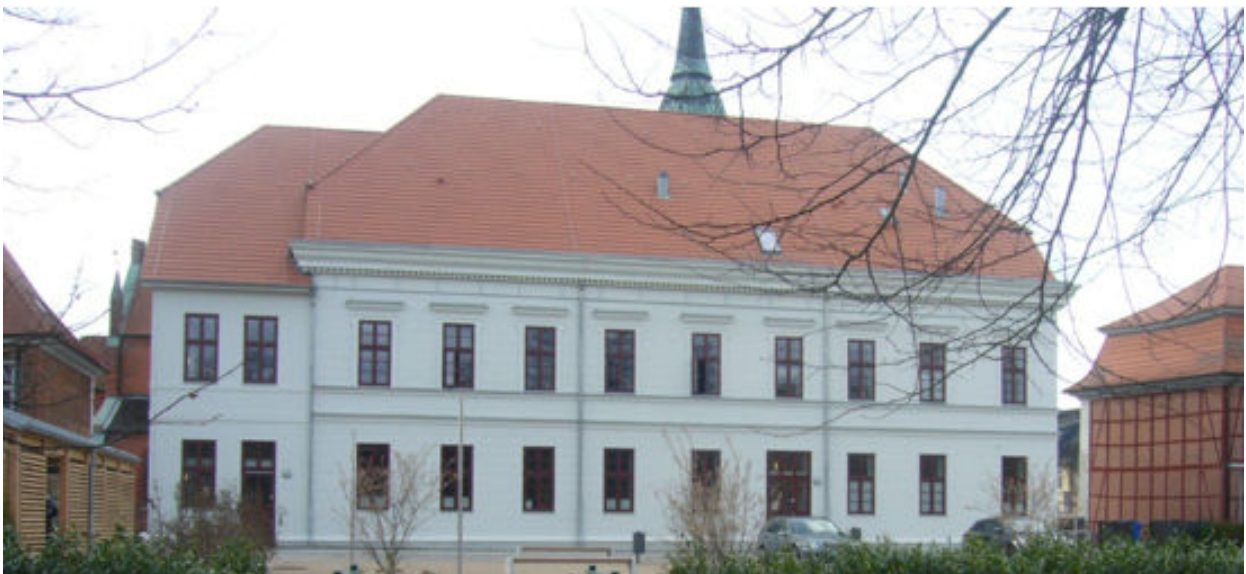
Kirchplatz 6: nach der Sanierung – Stadtverwaltung Rückseite
